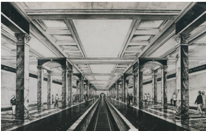
Проект станции «Стадион имени Сталина» («Партизанская») Центральный зал. (1937 г.) Архитектор Б. С. Виленский
